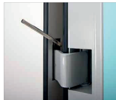
6 CERNIERA A SCOMPARSA registrazione orizzontale.
